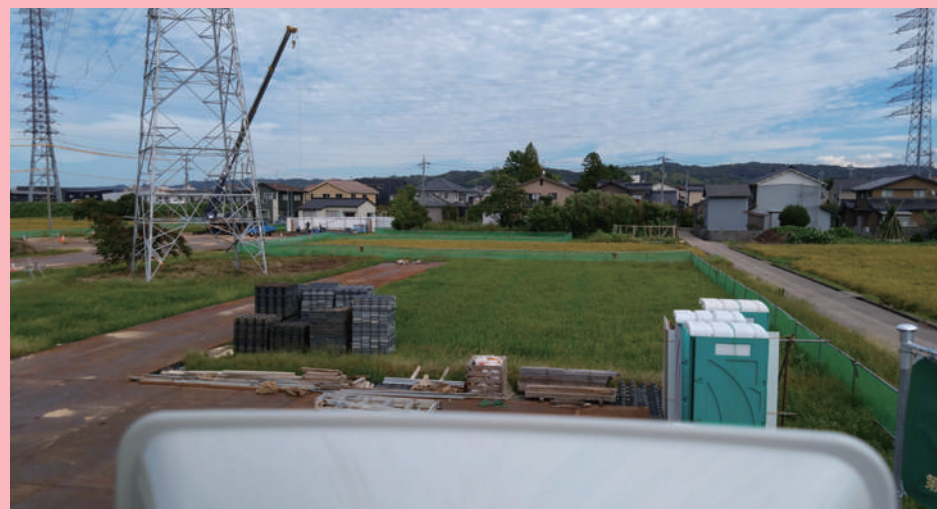
▲工事現場のカメラ映像
